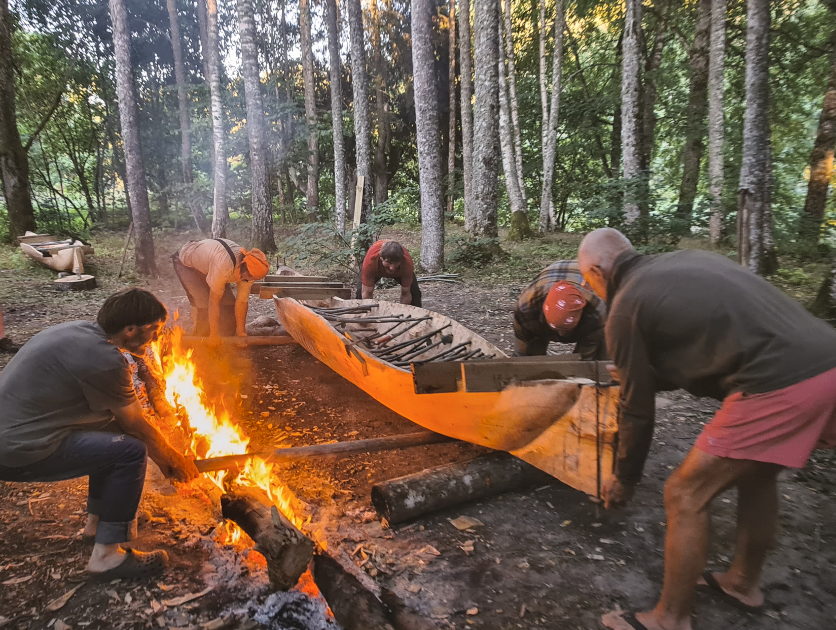
Lootsiku laotamine tule kohal on õõnespaadi ehituse kõige müstilisem osa. Saarisoos, 2016. Foto: Mati Kose
